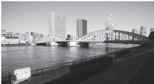
隅田川の左岸から見た勝鬨橋
